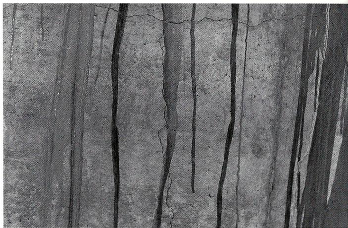
Foto/Photo 7 - Fessure da espansione termica visibili sotto colature di boiacca/Thermal expansion cracks visible under a pour of cement grout.
