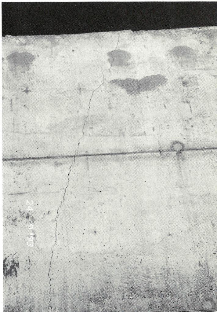
Foto/Photo 8 - Fessura da ritiro termico, passante e ad intera altezza, sul muro di una vasca di un impianto di depurazione, avente spessore di 70 cm/Thermal shrinkage cracks, through and of full height, in a sludge treatment plant tank wall, 70 cm in thickness.
