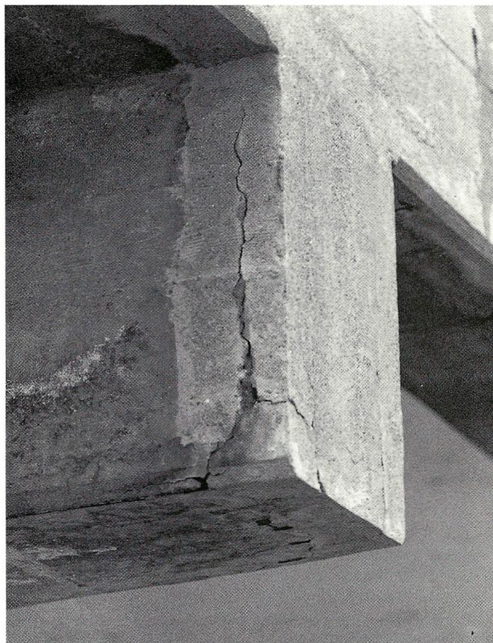
Foto/Photo 10 - Fessurazione dovuta alla corrosione dell'armatura/Cracking due to corrosion of reinforcement.
